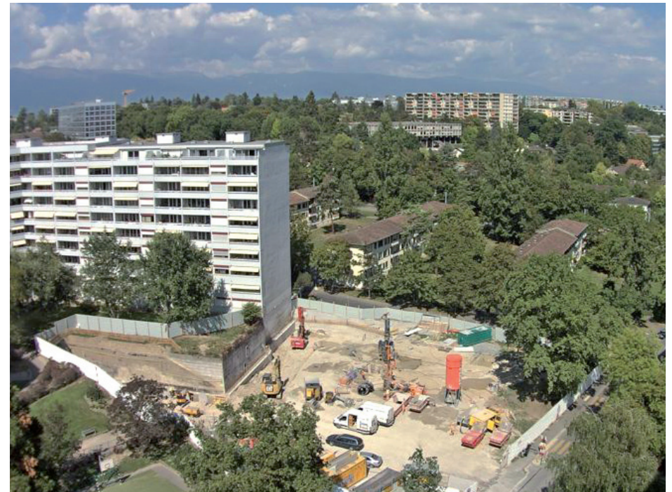
Vue aérienne du chantier
