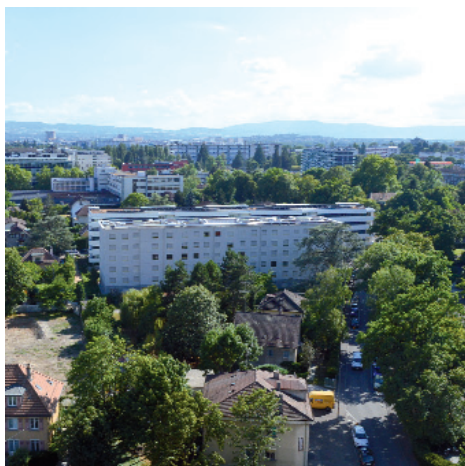
Immeuble Edouard-Rod, 4a, 4b, 4c
